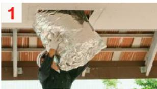
1 เปิดฝาแพคเกจหรือช่องเซอร์วิส เพื่อนำฉนวนกันความร้อน เอสซีจี รุ่น STAY COOL ขึ้นด้านบน (ขนาดช่องเซอร์วิส 60 x 60 ซม. เป็นอย่างน้อย)
