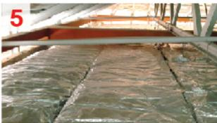
5 ปูฉนวนให้เต็มพื้นที่ และรอยต่อแผ่นฉนวนต่อชนกัน โดยอาจไม่ต้องติดรอยต่อด้วยเทปอลูมิเนียมฟอยล์
